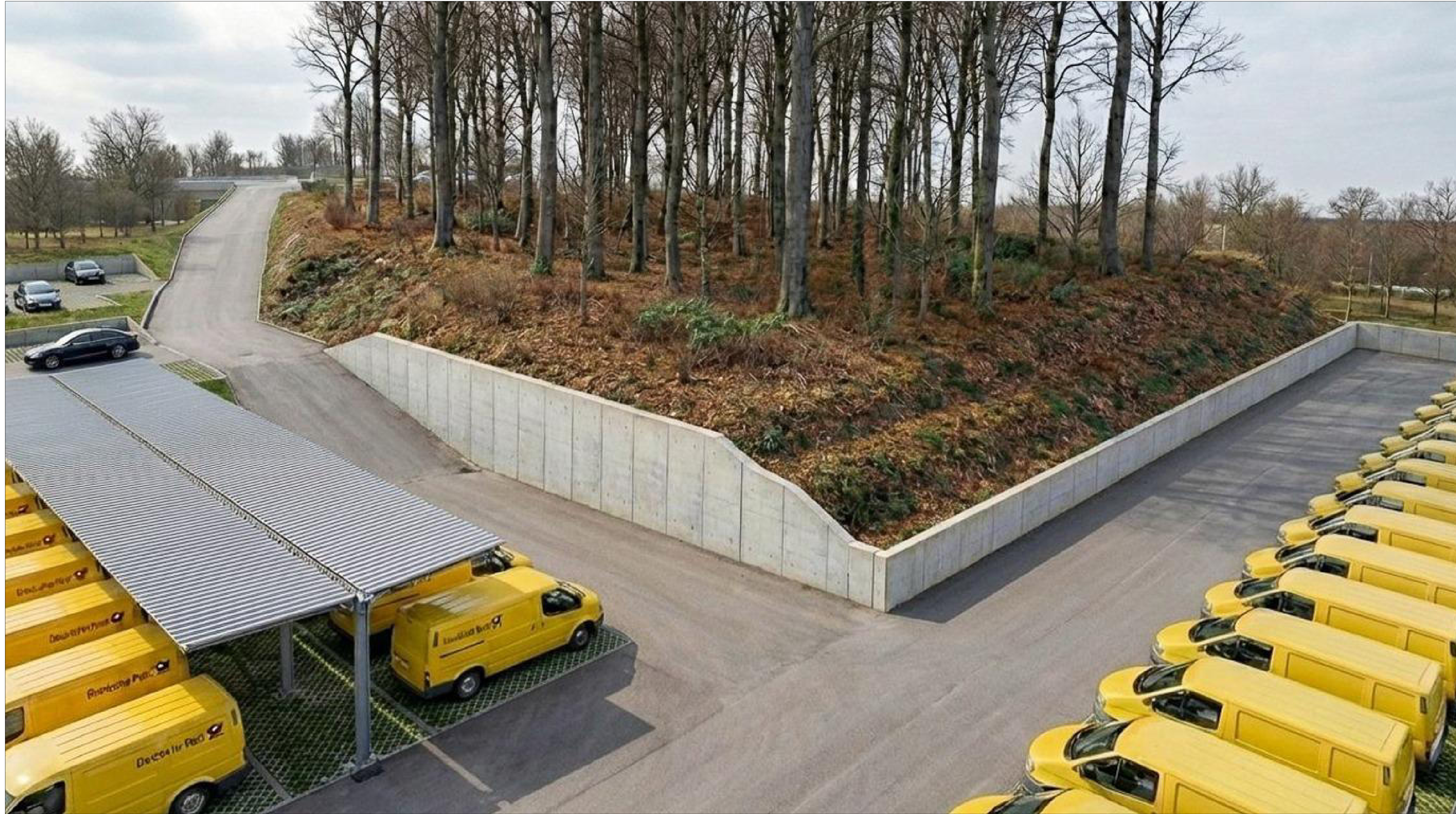
Stützwand Wald / erweiterte Böschung
