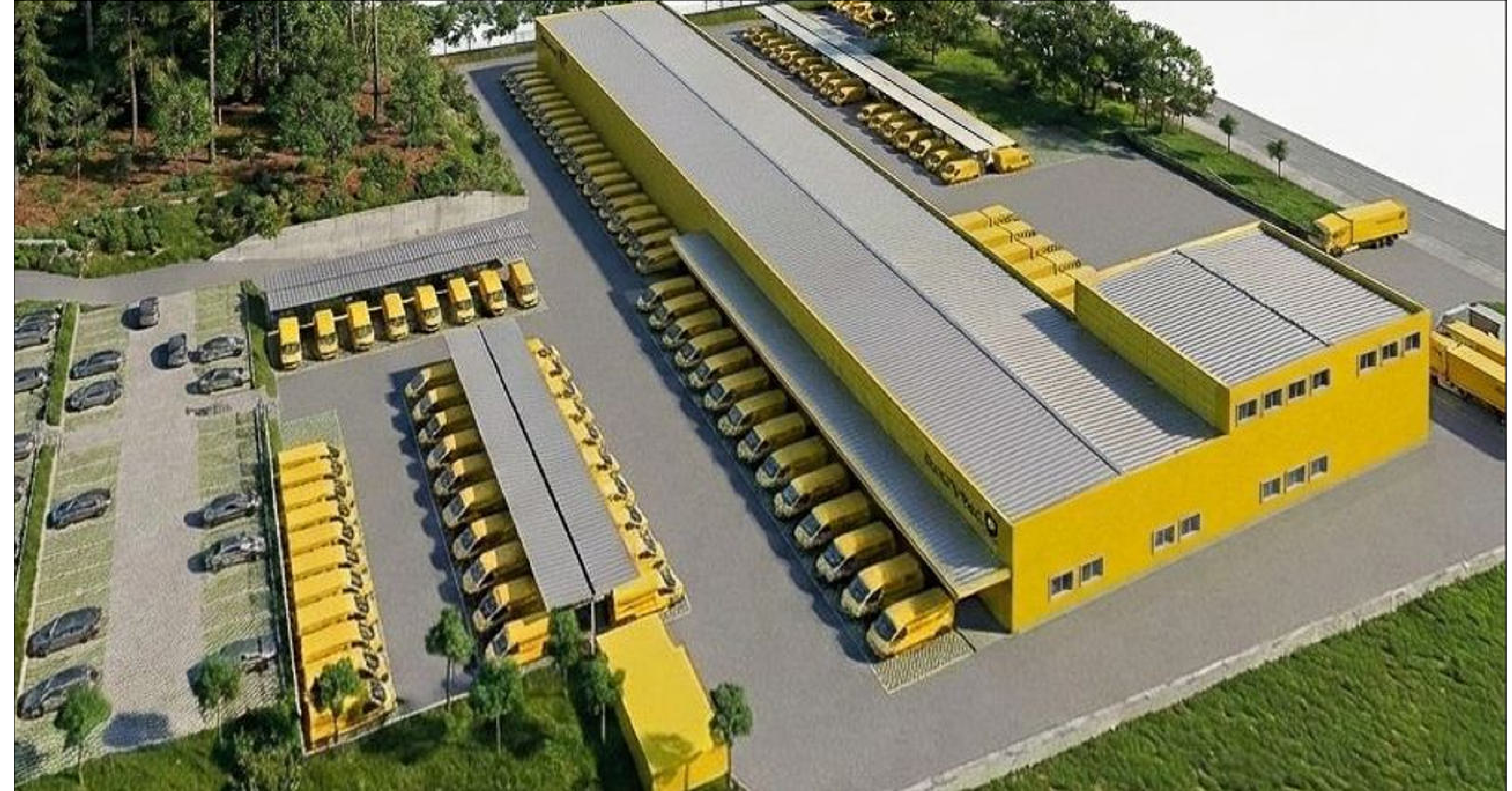
Rückwärtiger Hof / Carports / Stellplätze
