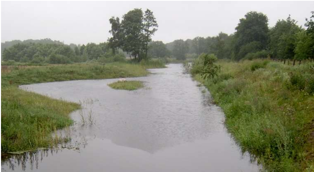
Regenrückhaltebecken vor Einleitung in Gewässer
