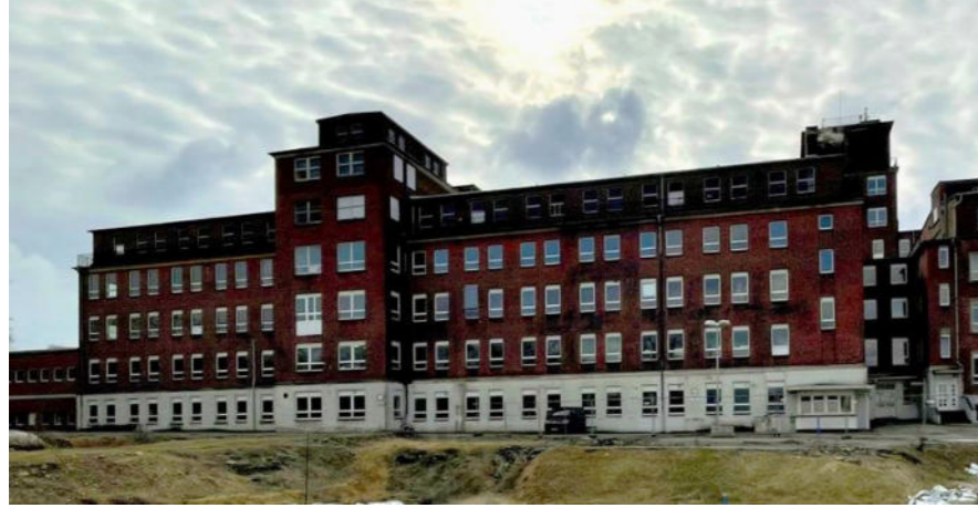
Bestand Gebäude 3/ 4/ 14 Ansicht von Norden
