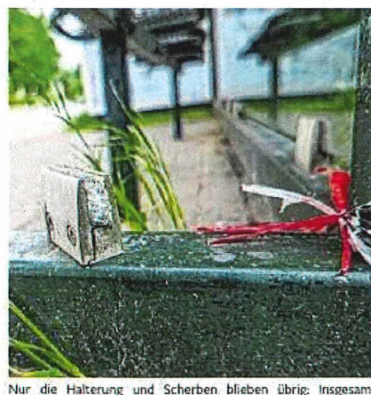
Nur die Halterung und Scherben blieben übrig: Insgesamt 29 Scheiben von Bushäuschen wurden in Wedel in den vergangenen Monaten zerstört.
