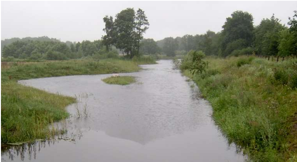
Regenrückhaltebecken vor Einleitung in Gewässer
