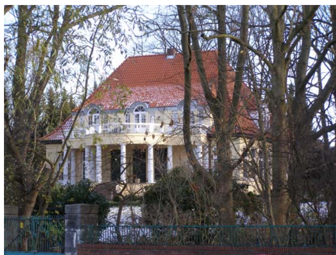
Villa Roggenhof Nr. 5 nach der Sanierung
