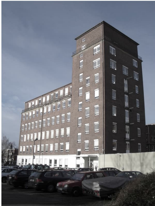
Bestand Gebäude 5 – der Wasserturm
