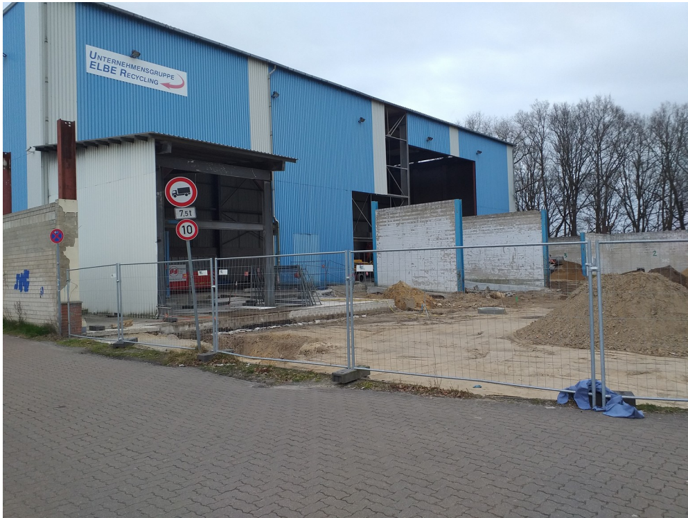
Baustelle Recyclinghof Puttener Weg/ Krons Kamp
