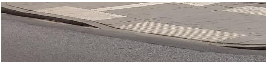
Abbildung 1: Beispiel einer getrennten Querung mit 0 cm und 6 cm (Quelle: eigene Aufnahme)
