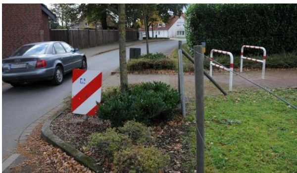
Abbildung 84: Vorgezogener Seitenraum (Bsp.)
