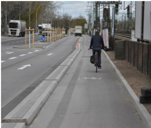
Abbildung 100: Beispiel für geschützten Radfahrstreifen (Hannoversche Straße, Hamburg)
