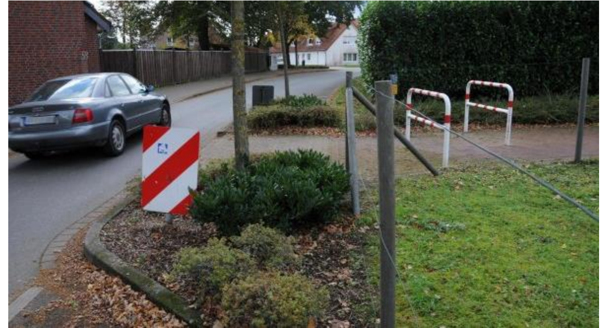
Vorgezogener Seitenraum mit Warnbarke (Quelle: Haller Kreiszeitung, 2020)
