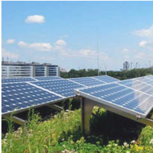
1 GRÜNDACH + PV Aktivierung der Dachflächen zur Energiegewinnung und Biodiversität
