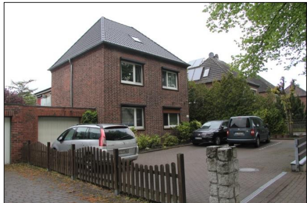
Stellplätze im Vorgartenbereich
