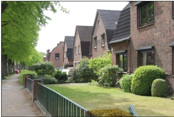
Südwestlicher Teilbereich nach Süden
