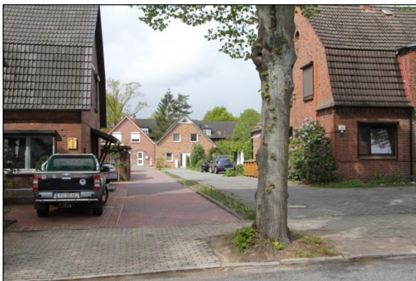
Fehlende Gliederung der Zufahrten
