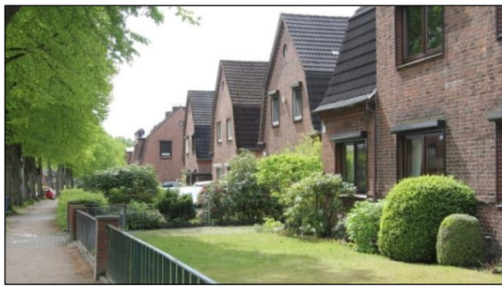
Südwestlicher Teilbereich nach Süden
