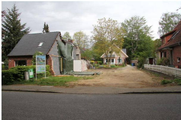
Teilabriss eines Doppelhauses
