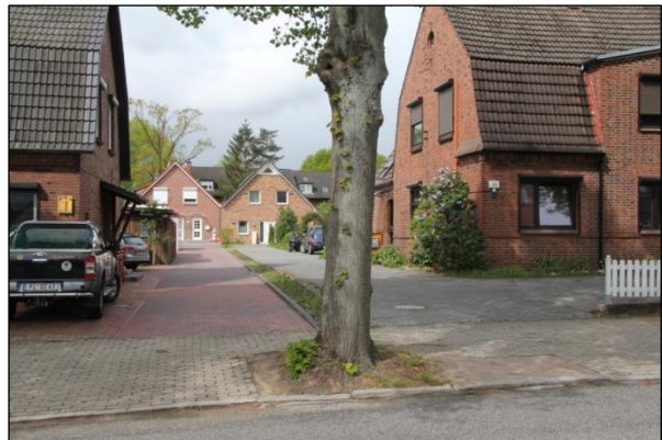
Stellplätze im Vorgartenbereich
