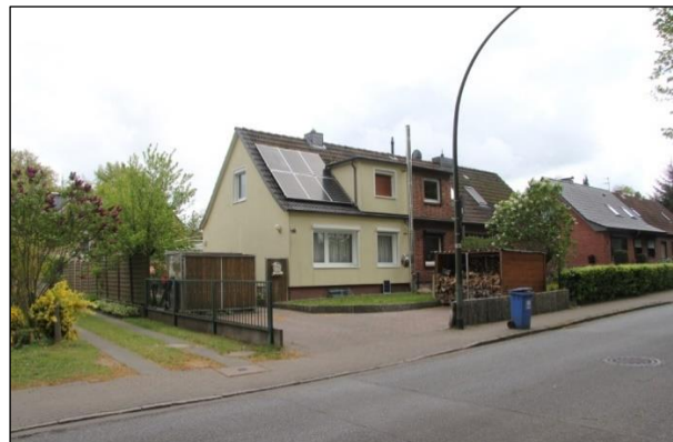
Solaranlage auf der straßenzugewandten Seite
