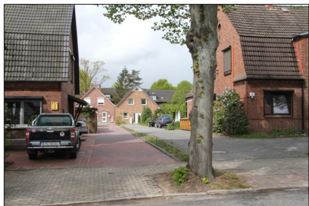
Fehlende Gliederung der Zufahrten
