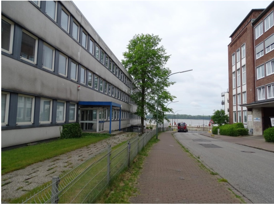
Abb. 10: Bergahorn an der Westseite des Bürokomplexes und Blick auf die Hafenstraße in Richtung Süden; Quelle: Elbberg Stadtplanung
