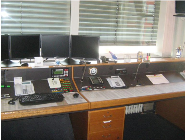
Zentrale Wedel von 1988
