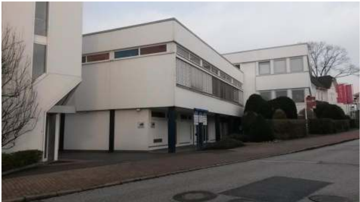
Foto 4: Hafenstraße 28a (Restaurant, Tanzschule) von Südosten
