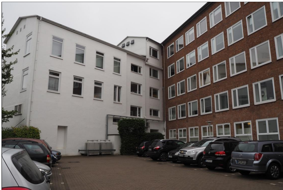
Abb. 2: Rückwärtige Ansicht der Gebäude Hafenstraße 30 bzw. 32 - Bruten des Mauerseglers sind sowohl im Bereich der Dachtraufe des mit roten Klinkern verkleideten Gebäudes (von den Bebauungs-Planungen nicht betroffen) als auch an den entsprechenden Strukturen des weiß gestrichenen Gebäudes links im Bild denkbar (zum Abriss vorgesehen).
