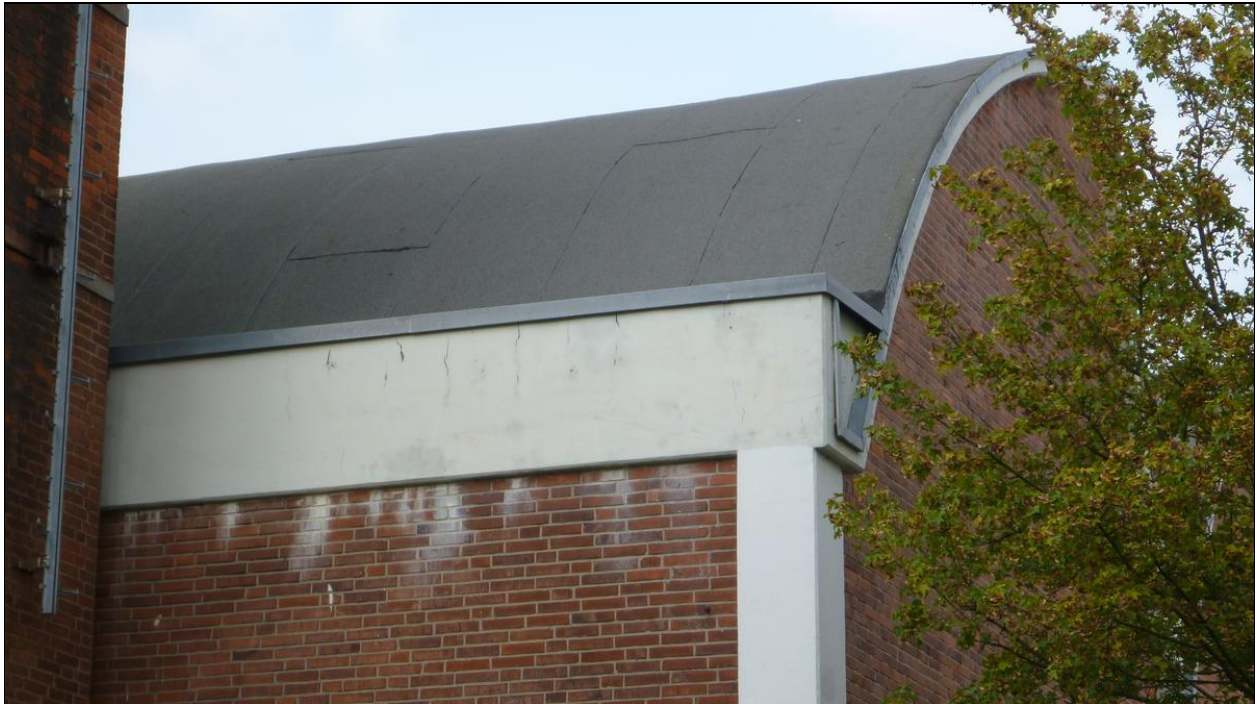
Abb. 6: Dachbereich an dem ehemaligen Fabrikgebäudes (Lager/Halle) auf dem Hof an der Hafenstraße 30. Einflugmöglichkeiten an der Attikaverkleidung und am Schornstein.
