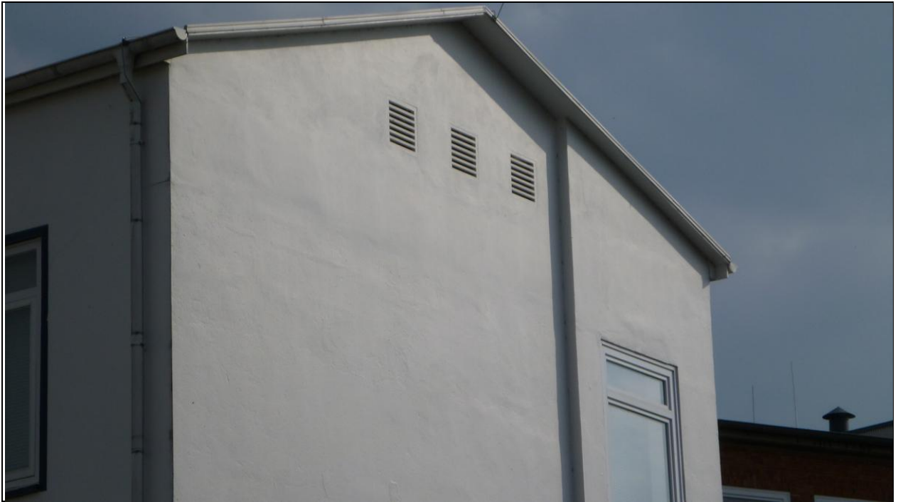
Abb. 4: Rückwärtige Ansicht der Gebäude Hafenstraße 30 bzw. 32 – Einflugmöglichkeiten an den Lüftungsschlitzen des weiß gestrichenen Gebäudes denkbar (Gebäudeteil ist zum Abriss vorgesehen).
