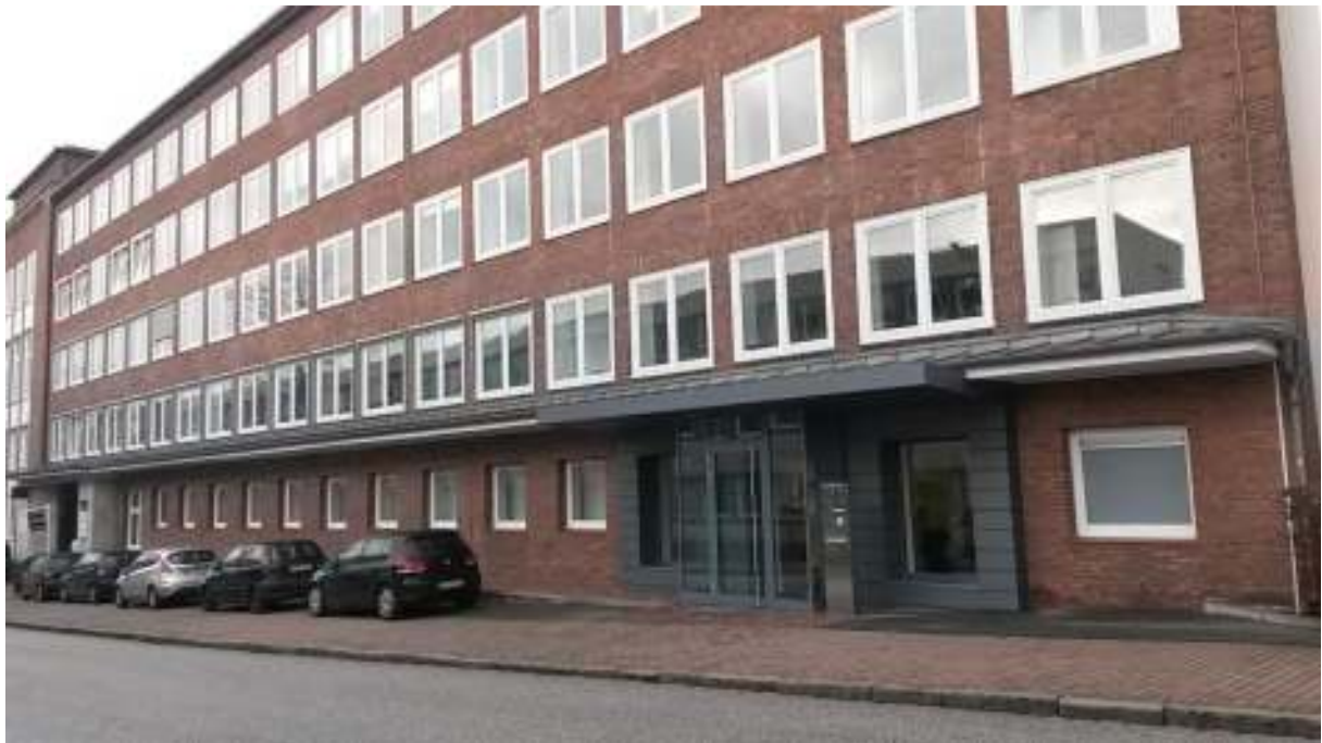
Foto 7: Hafenstraße 32 – 32b (Bürogebäude) von Nordosten
