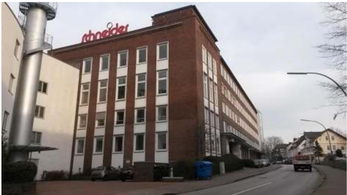
Foto 8: Hafenstraße 32 – 32b (Bürogebäude) von Süden
