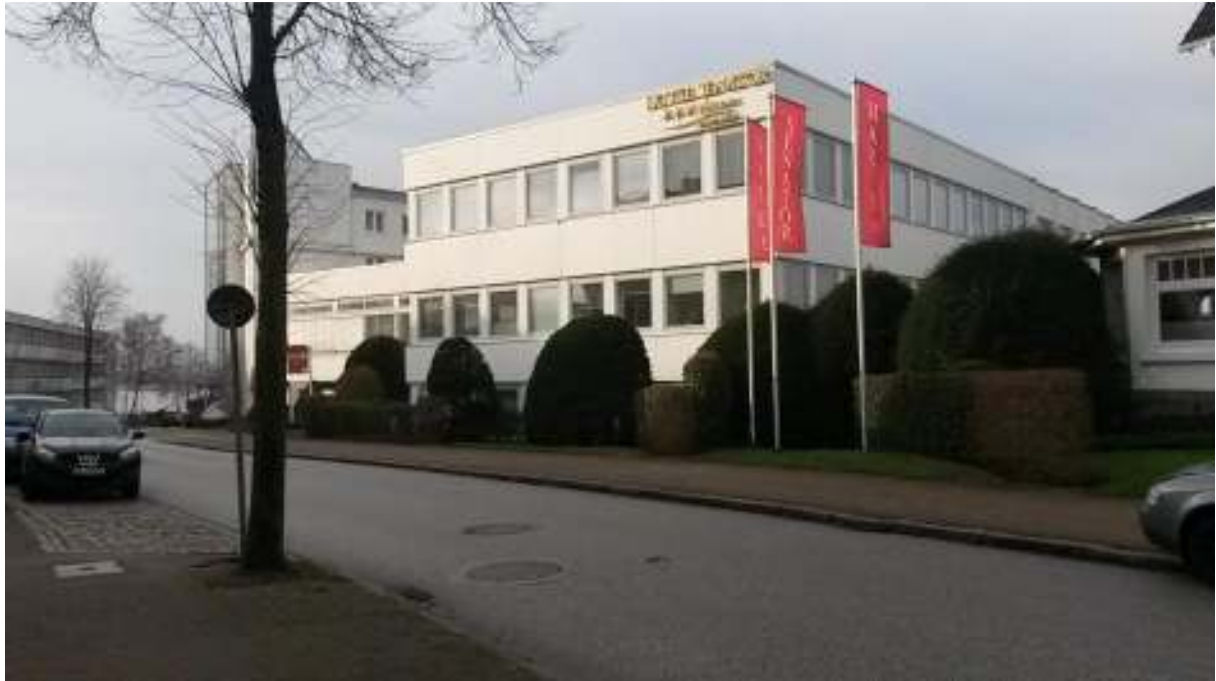
Foto 3: Hotel (Hafenstraße 28) von Nordosten
