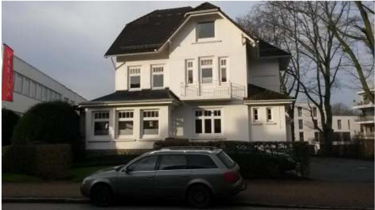
Foto 1: Hafenstraße 26 (Wohn- und Bürogebäude) von Osten
