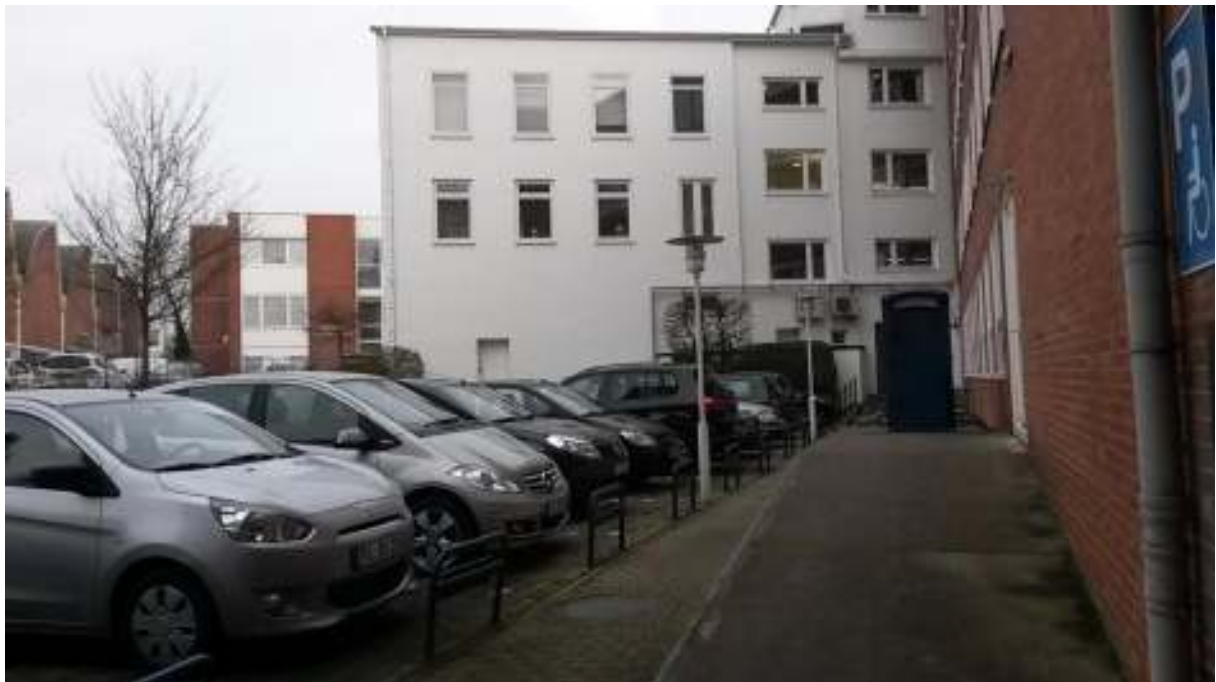
Foto 10: Hinterhof hinter Hafenstraße 32 – 32b von Süden
