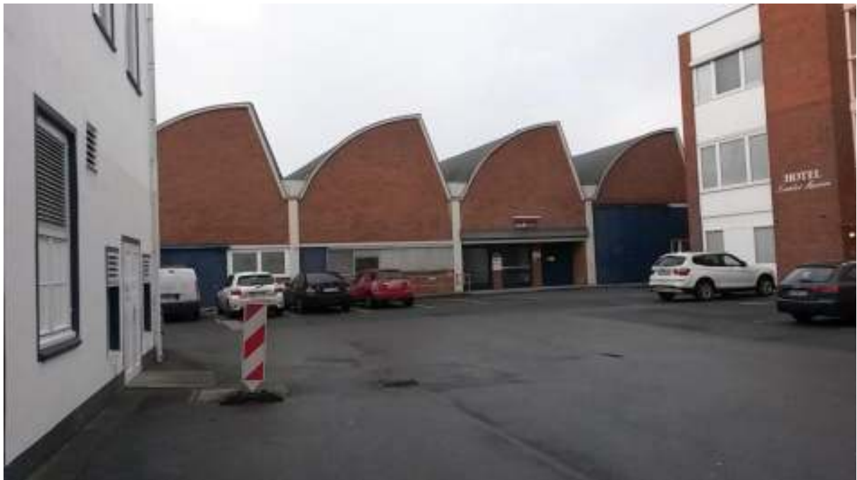
Foto 6: Hafenstraße 30 (Gewerbehalle) von Osten
