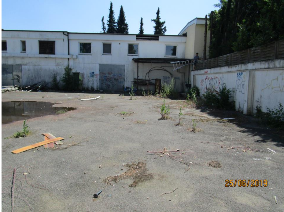
Foto 3: Blick nach Osten auf den Hofplatz in der Nordwestecke des Grundstücks.
