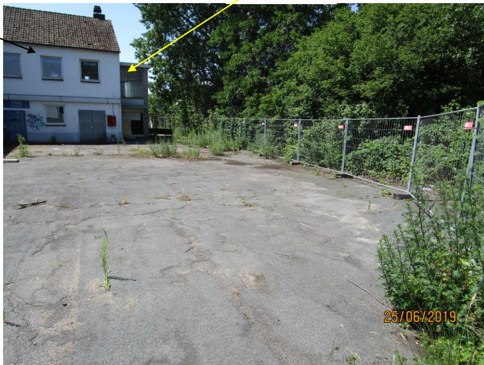
Foto 4: Blick nach Westnordwesten auf den Hofplatz in der Nordostecke des Grundstücks.
