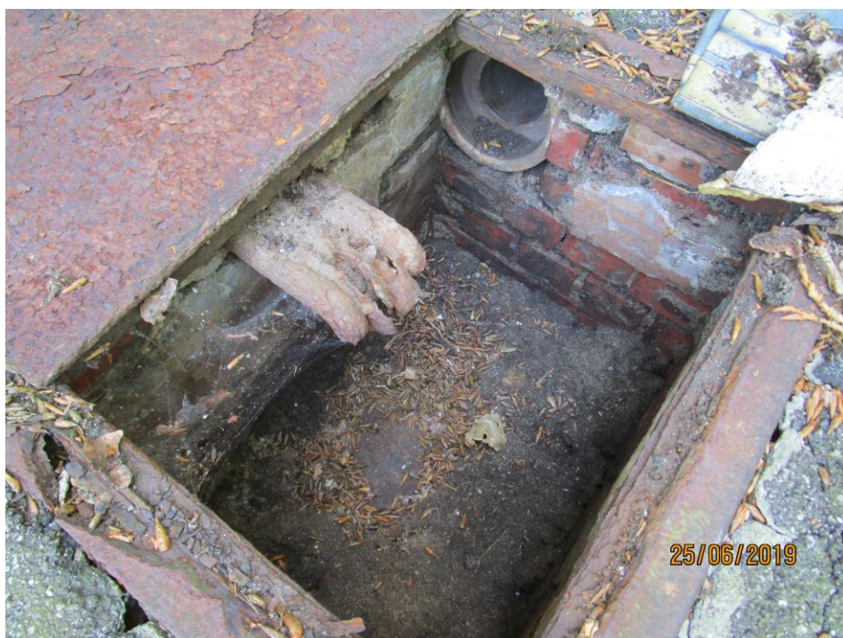
Foto 6: Detailfoto aus Foto 5; Schacht vor dem Treppenhaus.
