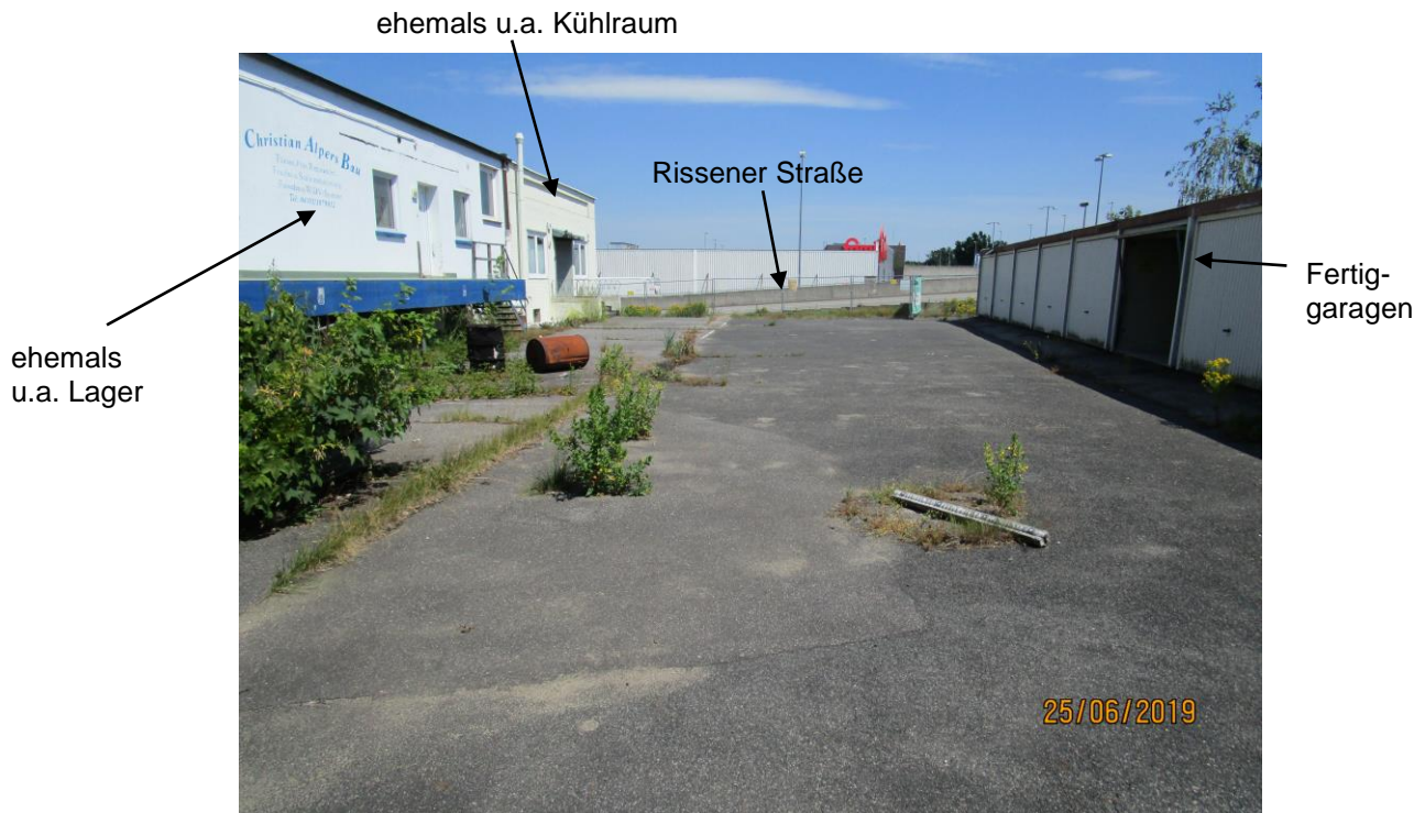
Foto 10: Blick nach Osten auf die Fertigaragen sowie den südlichen Teil des Gebäudebestands.
