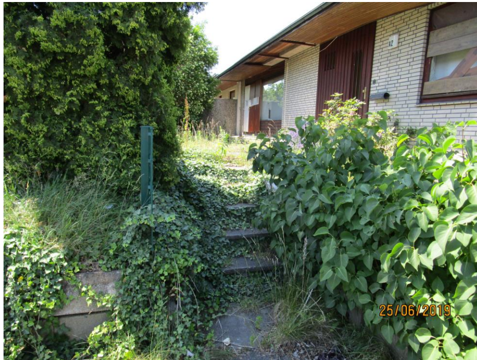
Foto 11: Blick nach Westnordwesten auf den Eingangsbereich des im EG als Wohnung genutzten Gebäudes. Nutzung des UG ehemals u. a. als Schlosserei.
